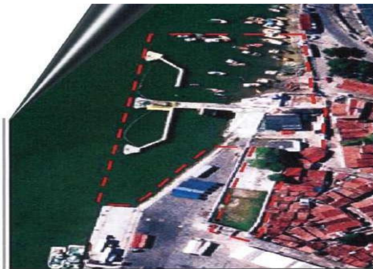
Fotografia 45 - Projeto Berço 04 englobando o antigo Pier de Combustível
