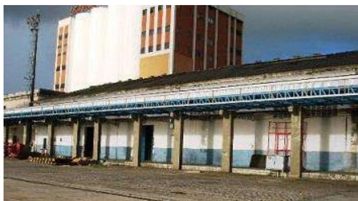
Fotografia16- Armazém nº 02 - lado do cais
