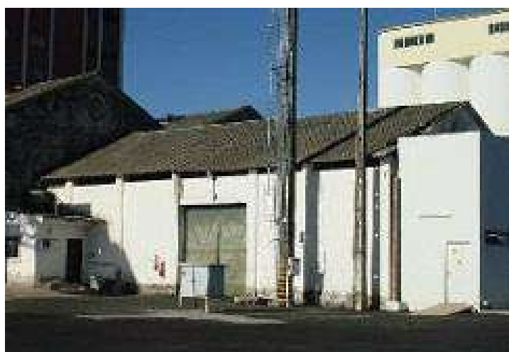
Fotografia15 - Galpão nº02 - lado do cais
