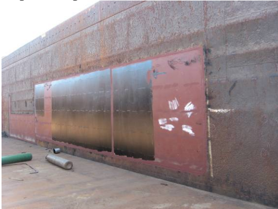
Reparo no porão
