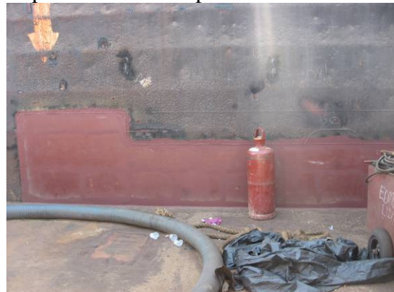
Reparo realizado no porão
