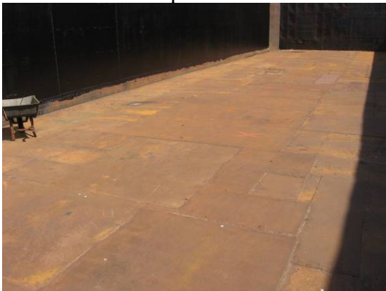
Vista do fundo do porão
