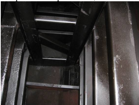
Tanque de lastro por boreste, a ré
