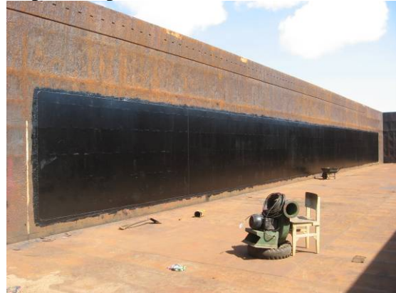
Reparo no porão
